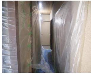
タイル浴室解体時
