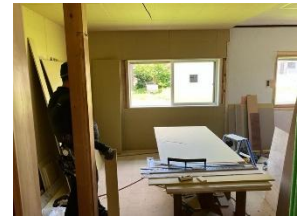
浴室工事でも、作業スペースとしてLDKを使わせていただく場合があります
