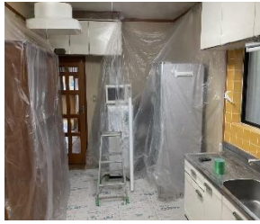
壁解体を伴うキッチンの解体時
