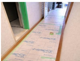
ユニットバス解体時
